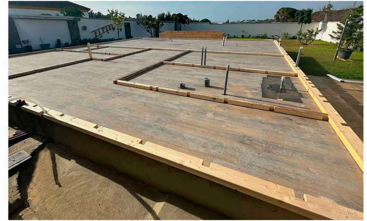
CIMENTACIÓN LOSA DE HORMIGÓN
